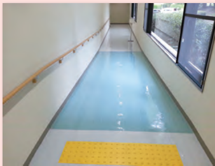
通路手すり有り
